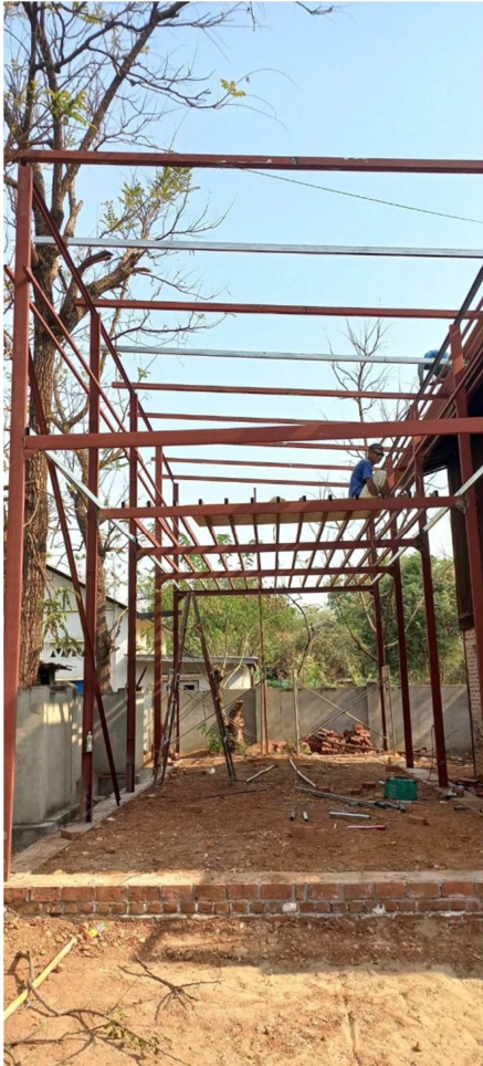
Hangar en cours de construction
