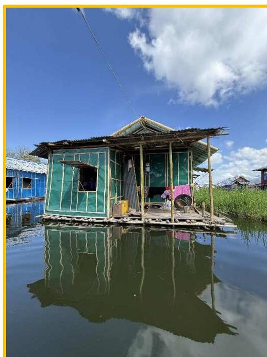
L'habitation après reconstruction financée par SOLIDAR'BIRMANIE
